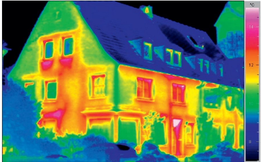
Fig. 2: Varmetab fra en dårligt isoleret beboelsesejendom. (Kilde: Verband Privater Bauherren e. V./ Bundesverband Deutscher Baustoff-Fachhandel e. V.)
